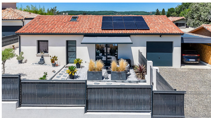
[Nestorwatt] Panneaux photovoltaïques sur toiture tuile
